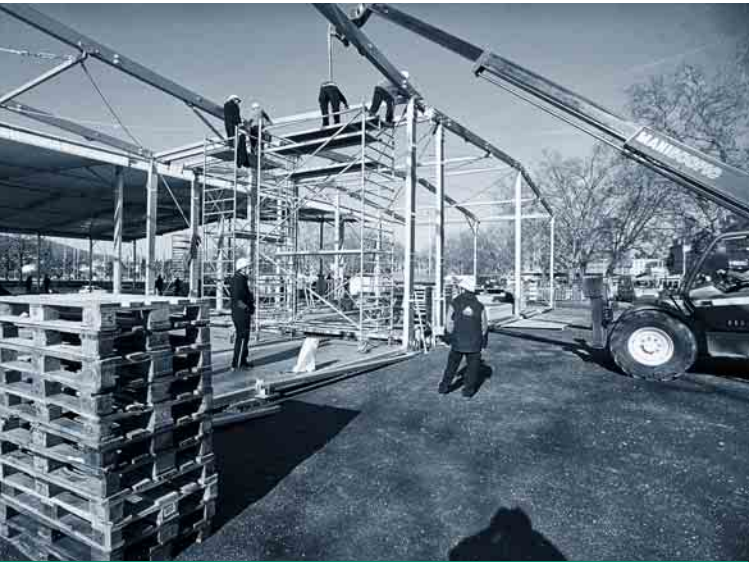
Aufbau des Pavillons für den «Parcours des Wissens» auf dem Sechseläutenplatz
